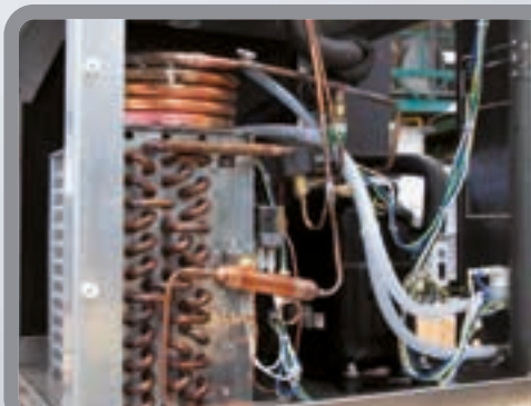
Condensazione mista Mixed cooling.
