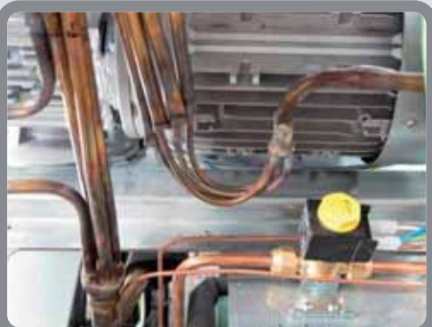
Iniezione a gas con sistema multipoint. Gas injection with multipoint system.
